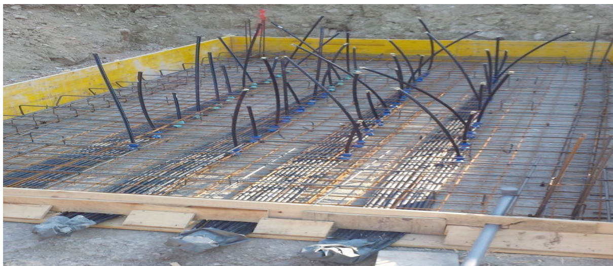
Slika 19: Prikaz ugradnje piezometara kroz temeljnu ploču.
