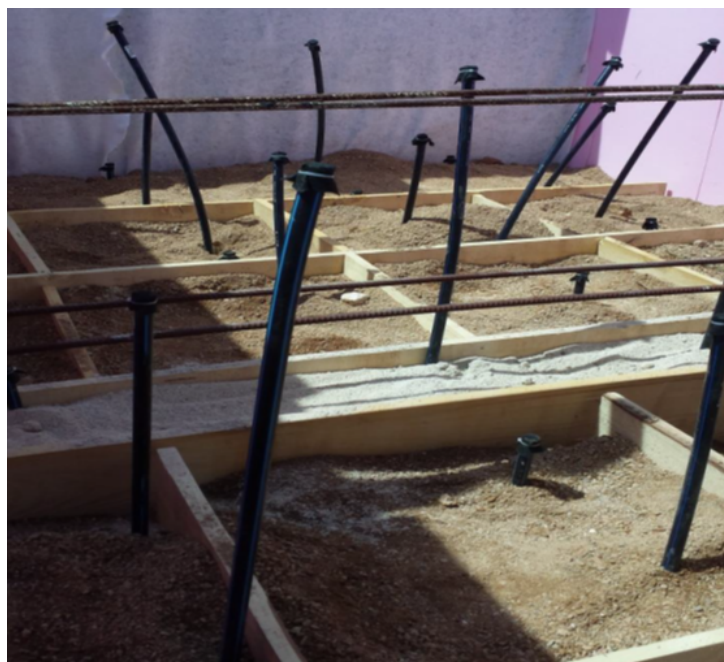
Slika 4: Proces punjenja bazena agregatom.
