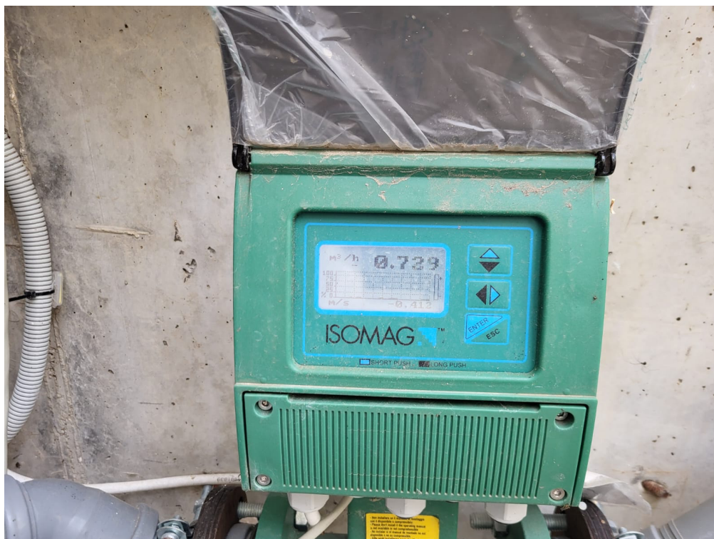
Slika 12: Digitalni mjerač protoka kanala tipa ISOMAG.
