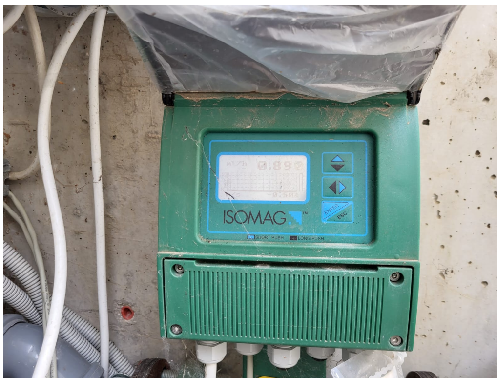
Slika 13: Digitalni mjerač protoka matrice tipa ISOMAG.
